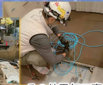
その他電気工事 (弱電工事)
