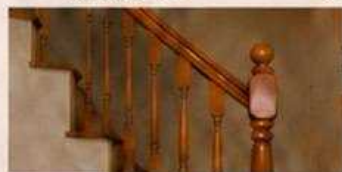
階段の手すり設置
