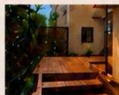
ウッドデッキ施工
