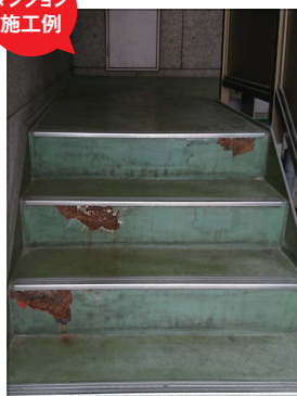
マンション 施工例
